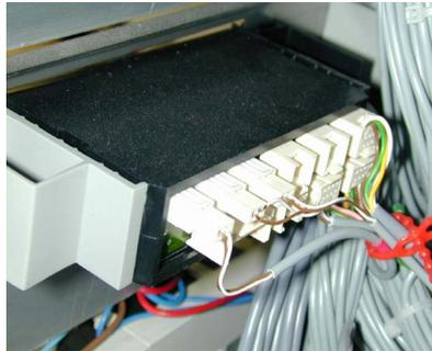
Abb. 4: Anschlüsse für vorkonfektionierte Kabel
