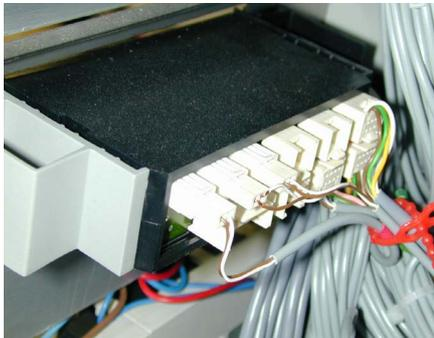
Abb. 4: Anschlüsse für vorkonfektionierte Kabel
