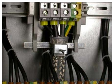
Raccordement d'un câble blindé dans le bornier
