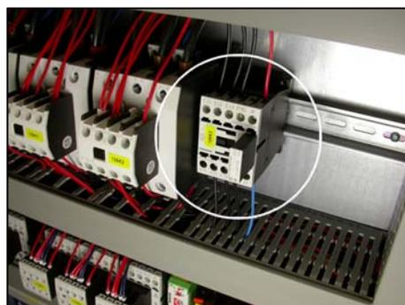
Branchement d'une bobine de protection avec combinaison RC
