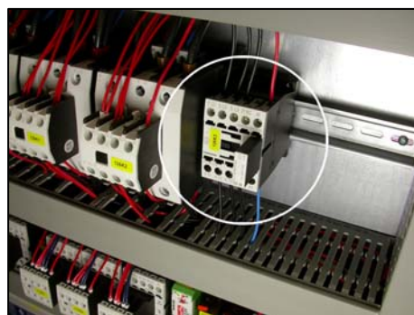
Collegamento di una bobina dei contattori con combinazione RC
