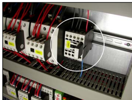
Włączanie cewki ochronnej przy pomocy kombinacji RC
